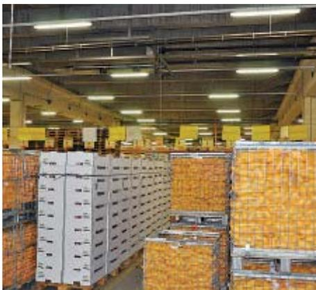
Die Beleuchtungsanlage im Frischdienstlager ist 1984 errichtet worden. Durch eine ungünstige Anordnung der Lichtbänder und eine Verlustleistung wegen Veralterung verursachte die Anlage bei fast durchgehendem Betrieb einen Jahresstromverbrauch von rund 243.000 kWh.
