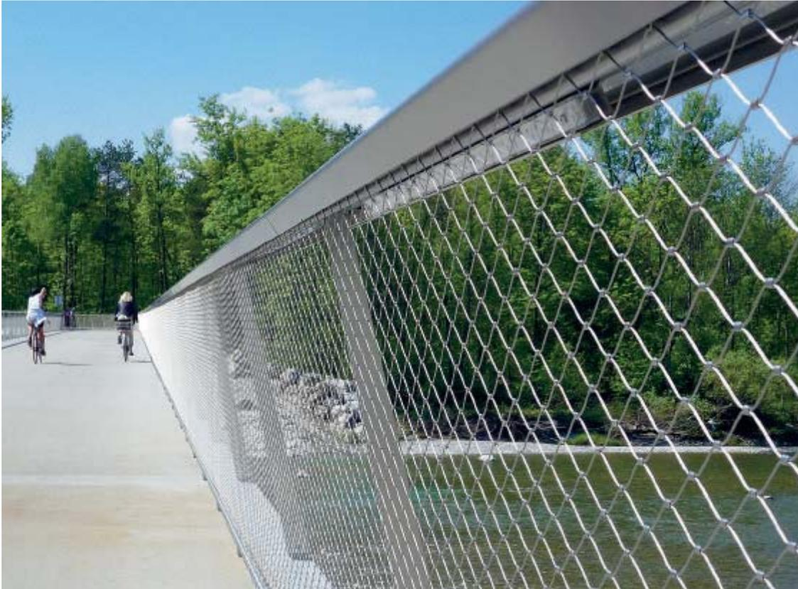
Die LED-Beleuchtung auf der Radbrücke reduziert in Verbindung mit Effizienzmaßnahmen bei der Straßenbeleuchtung im Umfeld sowohl den Stromverbrauch als auch den Lichteintrag ins sensible Naturschutzgebiet. Der Lichteintrag ist – auch dank der im Geländer eingebauten Leuchtkörper – trotz zusätzlich beleuchteter Routenstrecke und hohem Komfort- und Sicherheitsanspruch für bis zu 4.000 NutzerInnen täglich nicht angestiegen.
